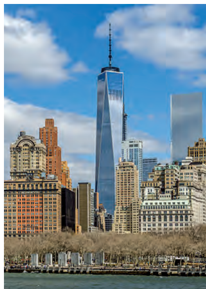
3 novembre. Il One world trade center, edificio principale del nuovo complesso sorto al posto delle Torri gemelle (per cortesia Macieck Lulko)
